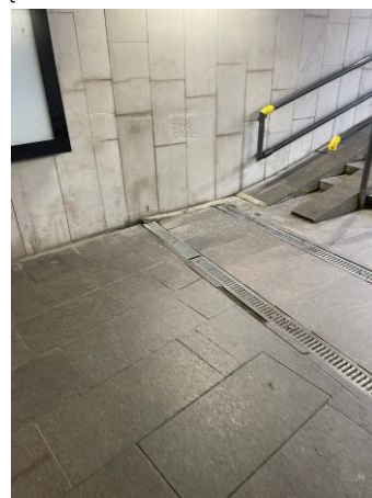
6. Pėsčiųjų tunelio plokščių, vandens latakų dabartinė situacija. Plokščių ir latakų būklė nepatenkinama, nusidevėjusi.
