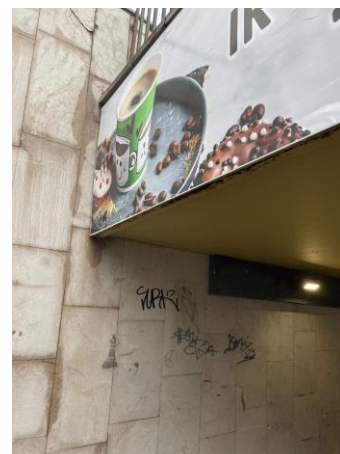
8. Pėsčiųjų tunelio sienų plokščių dabartinė situacija. Esamos tunelio sienos yra praradusios savo spalvą, nusidevėjusios, vietomis suskilusios, pažeistos vandens, atsiradusios rūdys.
