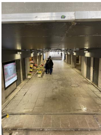
3. Pėsčiųjų tunelio požeminė erdvė. Esamo tunelio apdailinės fasadų, grindų dangos ir elementai nusidevėję, trūksta apšvietimo sprendinių.
