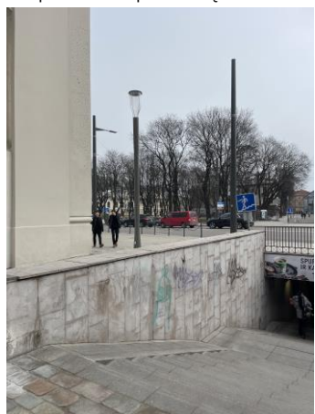
5. Pėsčiųjų tunelio sienų plokščių dabartinė situacija. Esamos tunelio sienos yra praradusios savo spalvą, nusidevėjusios, vietomis suskilusios, pažeistos vandens.
